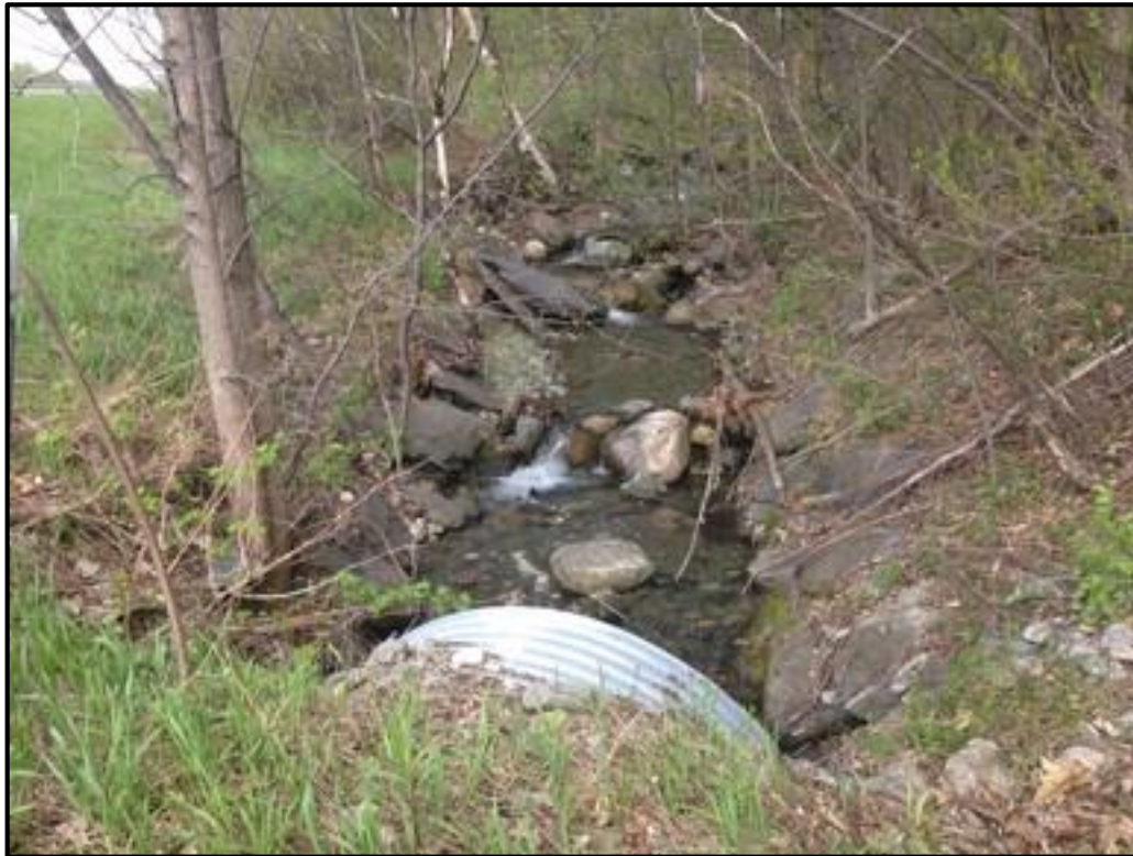
T-IR-S4 Culvert Inlet
