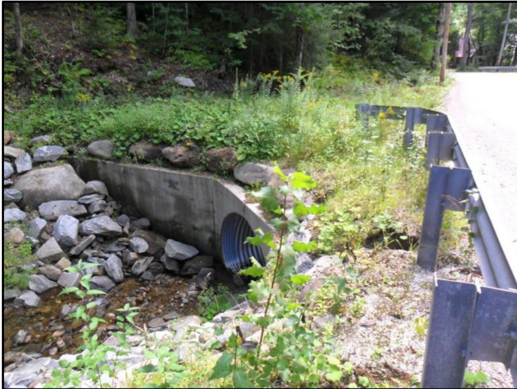
T-LU-S20 Culvert Inlet
