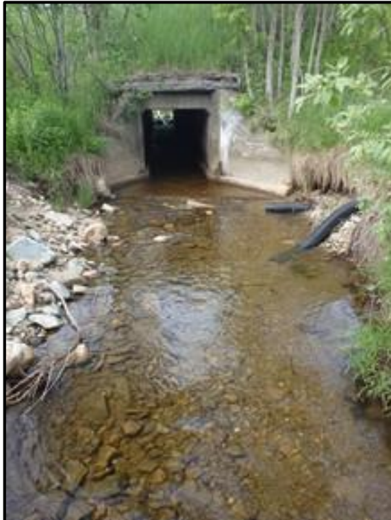
T-MH-S37 Culvert Outlet
