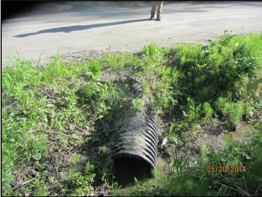
V-BE-AS-3 Culvert Inlet
