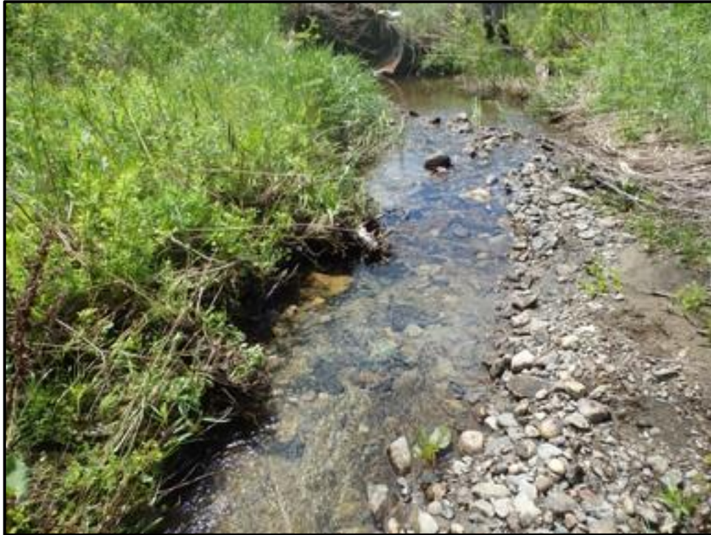
T-MH-AS-23 Culvert Outlet
