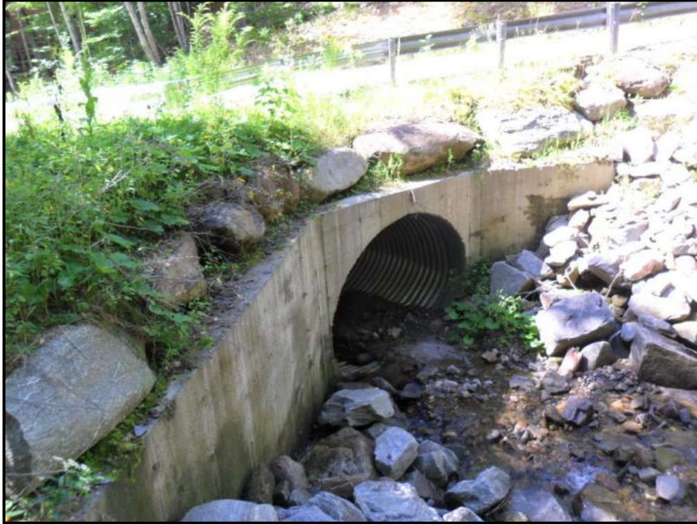
T-LU-S20 Culvert Inlet
