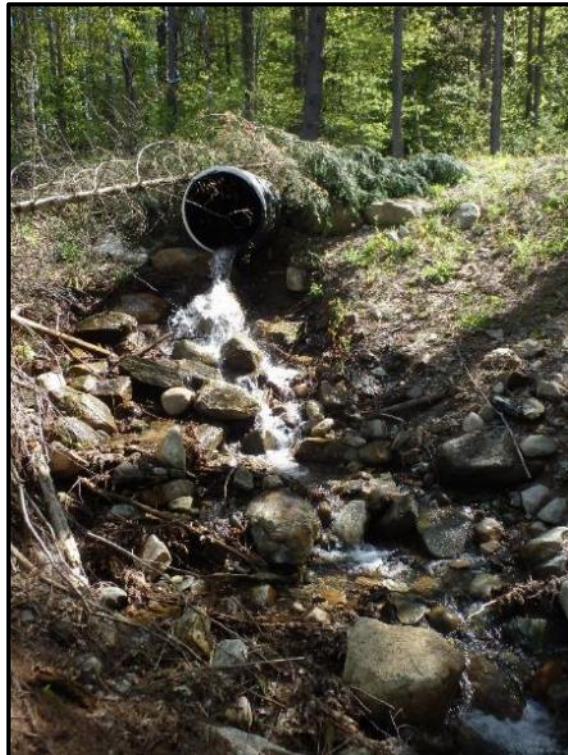
T-LU-S15 Culvert Outlet
