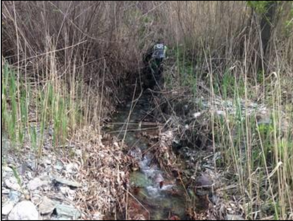
T-WR-S34 Culvert Outlet
