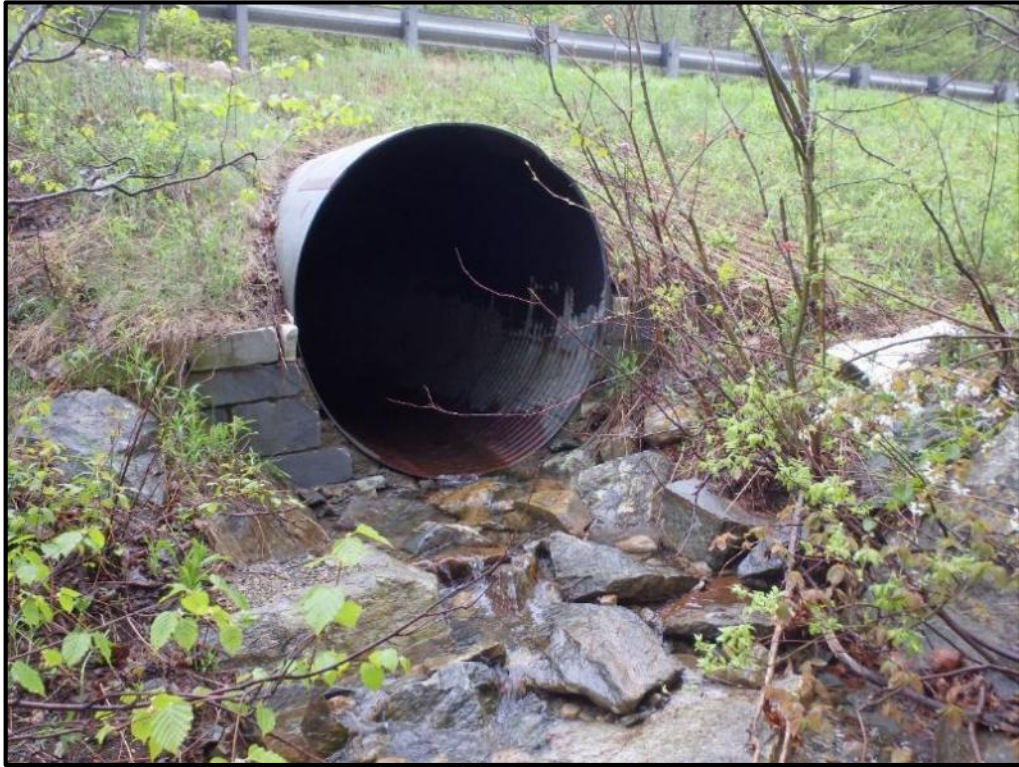
T-MH-S1 Culvert Outlet
