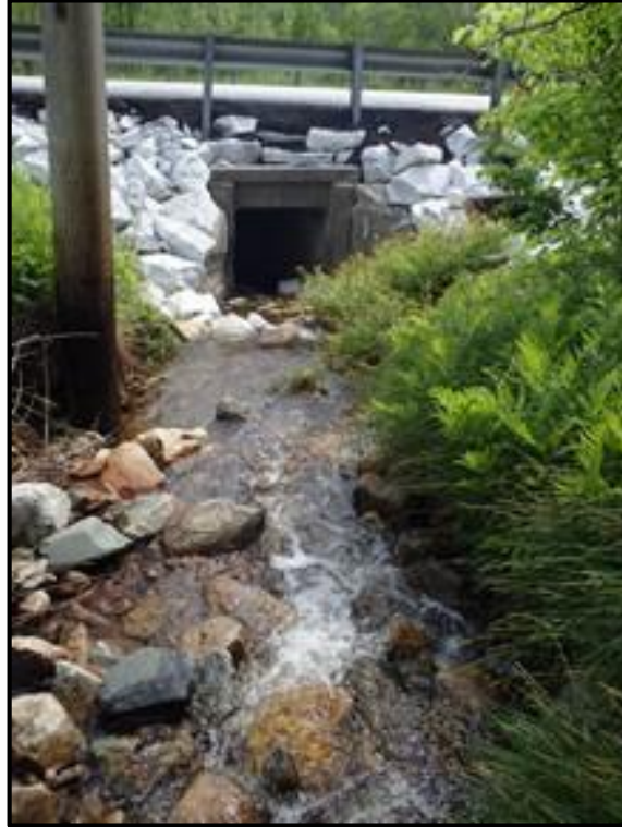
T-MH-S37 Culvert Inlet
